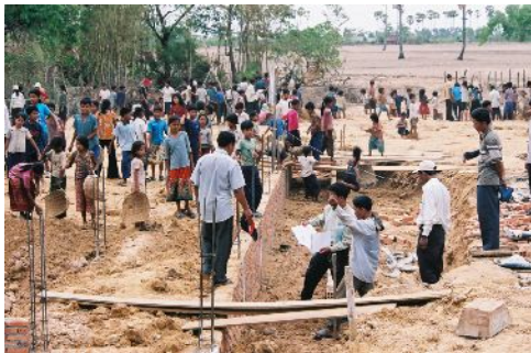
住民総出で行う基礎の「土盛り」作業
