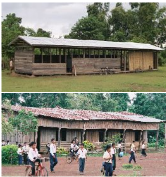
老朽化した校舎
