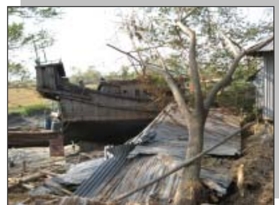
全壊したゴノケンドラ(手前)と座礁した船(奥)
