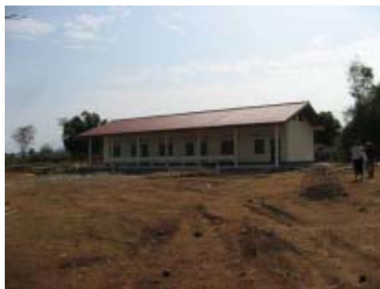
現在建設中の校舎、もうすぐ完成予定
