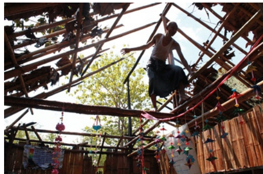
図書スペースの天井
