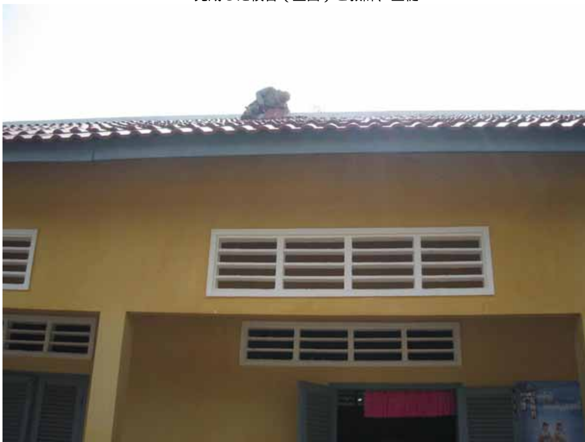
業者による壊れた屋根瓦 2 枚の取替え
